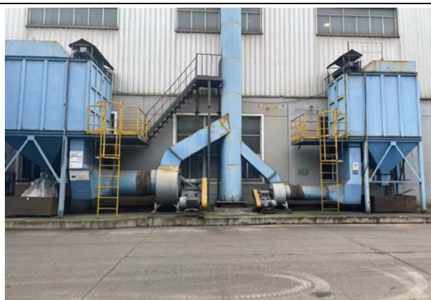
埋箱和震实工段、砂处理工段分别使用吸风罩捕集后，分别经袋式除尘器
