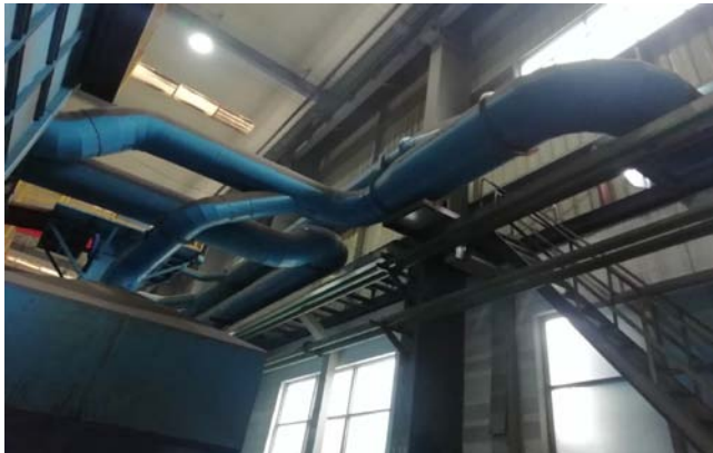
消失模黑区车间砂处理工段经袋式除尘器收集处理，处理设施进口和处理设施出口均管径距离不足，满足不了开孔要求
