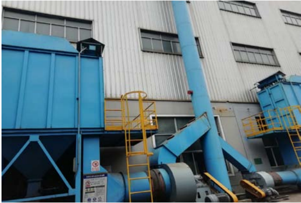
消失模黑区车间埋箱、震实工段处理设施进口现场作业空间不足，无法满足安全监测平台要求，处理设施出口管径距离不足，满足不了开孔要求
