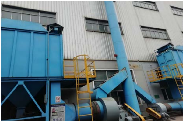
消失模黑区车间砂处理工段经袋式除尘器收集处理，处理设施进口和处理设施出口均管径距离不足，满足不了开孔要求
