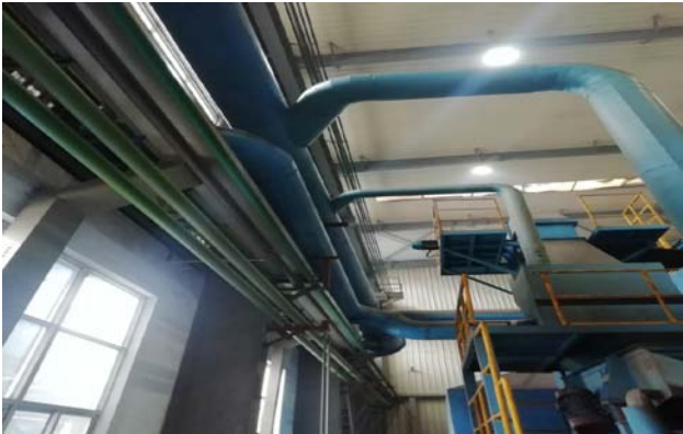
消失模黑区车间埋箱、震实工段处理设施进口现场作业空间不足，无法满足安全监测平台要求，处理设施出口管径距离不足，满足不了开孔要求
