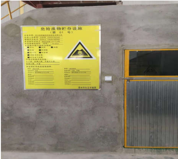
危险废物堆场观察窗和标志牌
