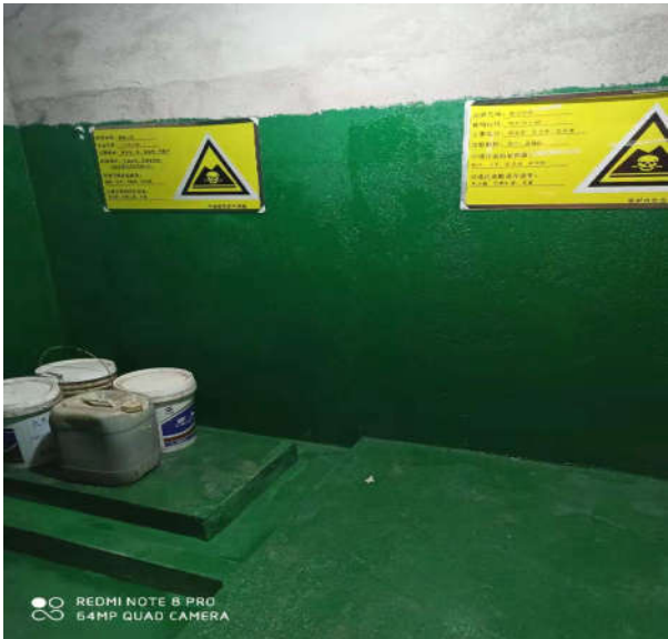
危险废物堆场内部
