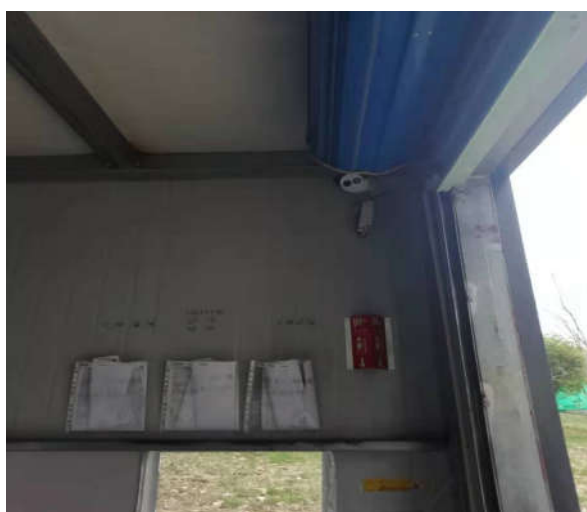
厂区北侧危废暂存库内部视频
