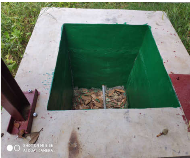
厂区北侧危废暂存库收集井位于库房外（西侧）
