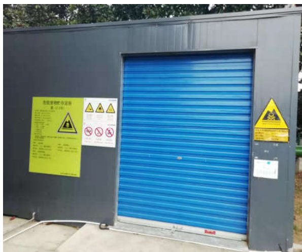
厂区北侧危废暂存库外部
