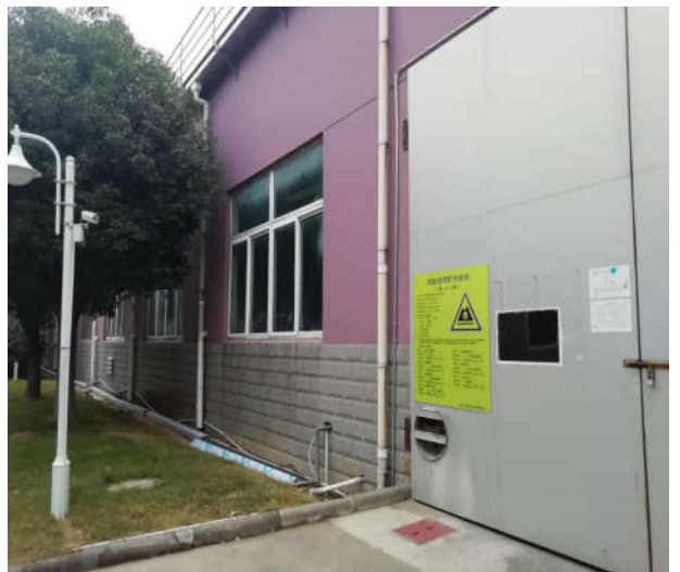
车间一危废暂存库外视频监控
