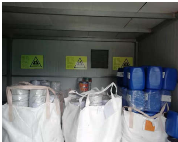
厂区北侧危废暂存库内部
