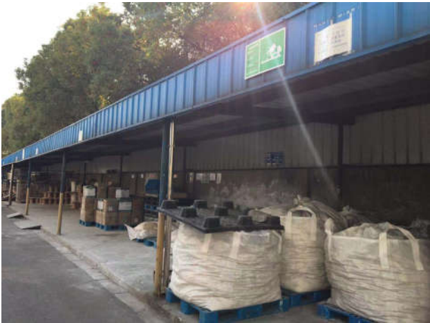
一般固废堆场 GF-02
