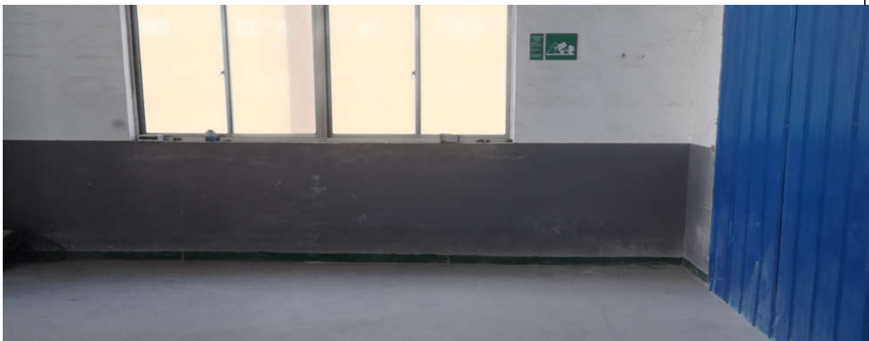
一般固废暂存库
