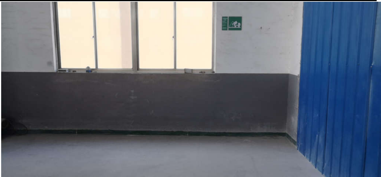
一般固废暂存库
