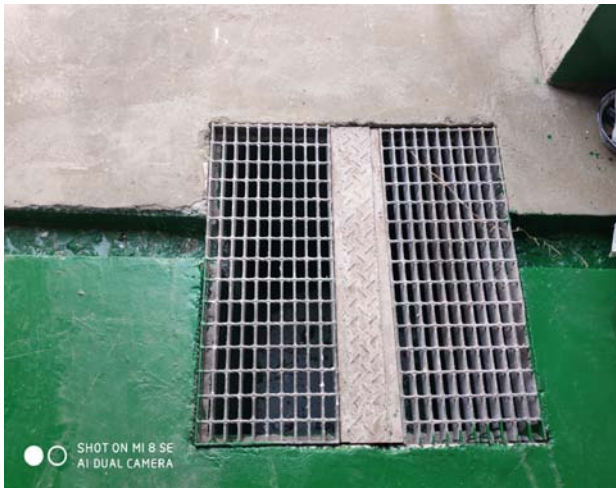
车间一危险废物贮存场收集井
