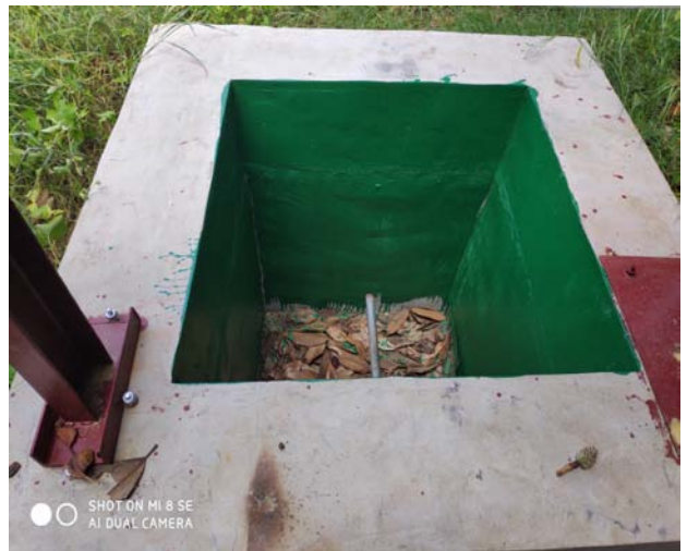
厂区北侧危险废物贮存场收集井
