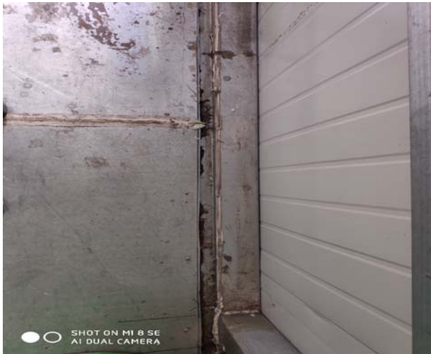
厂区北侧危险废物贮存场导流沟
